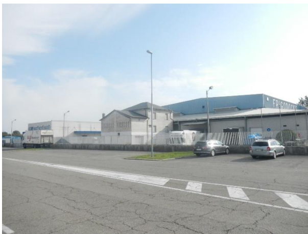
Foto 1 . Vista del fabbricato posto su viale Italia dove è stata realizzata la stazione fonometrica della durata di 48 ore
